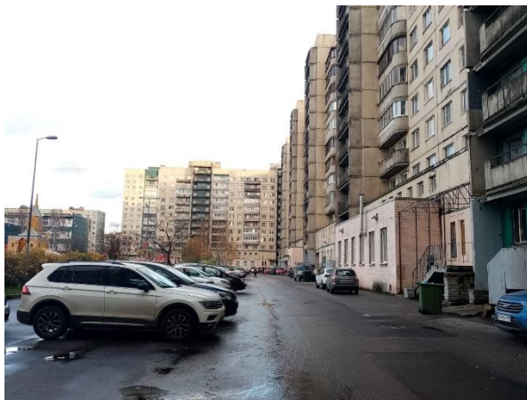
Фото 3. Вид здания Объекта оценки. Дворовая территория
